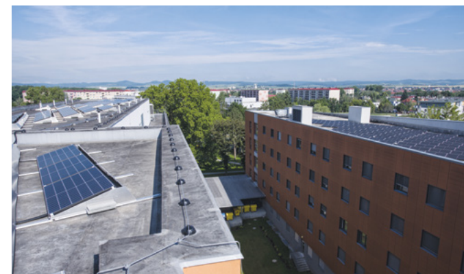
Fotovoltaické panely Uherskohradištské nemocnice dotace: 884 931 Kč
