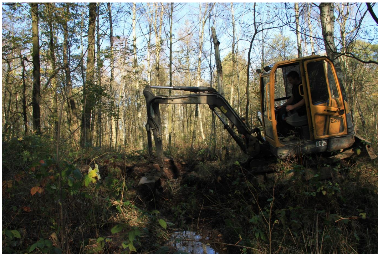
Obrázek 2 Nové koryto ještě před zahrazením stávajícího koryta
