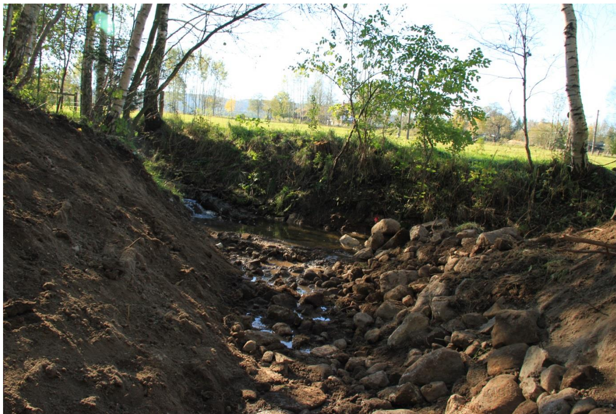
Obrázek 2 Nové koryto ještě před zahrazením stávajícího koryta
